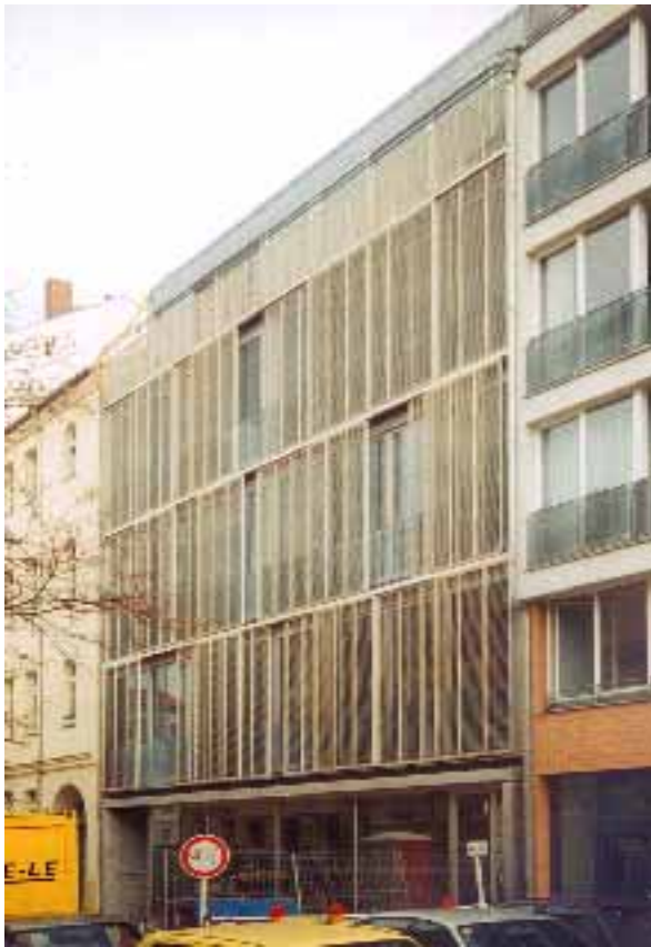
Straßenfassade in Form einer vollständig in Glas aufgelösten Wandfläche
