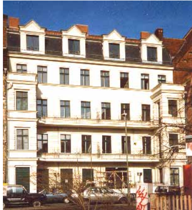
Auguststraße 91 mit wiederhergestellten Dachgauben, 1998
