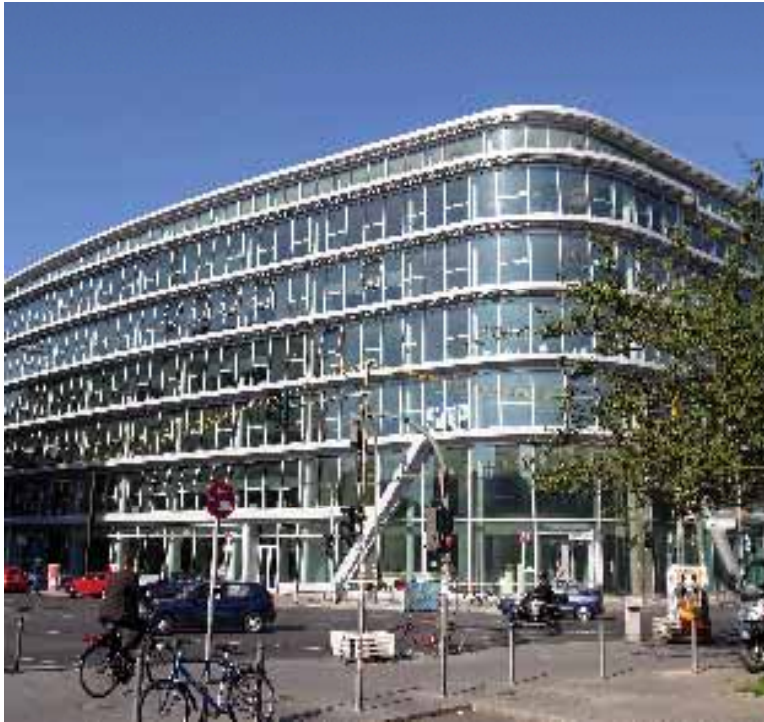
Straßenfassade in Form einer vollständig in Glas aufgelösten Wandfläche
