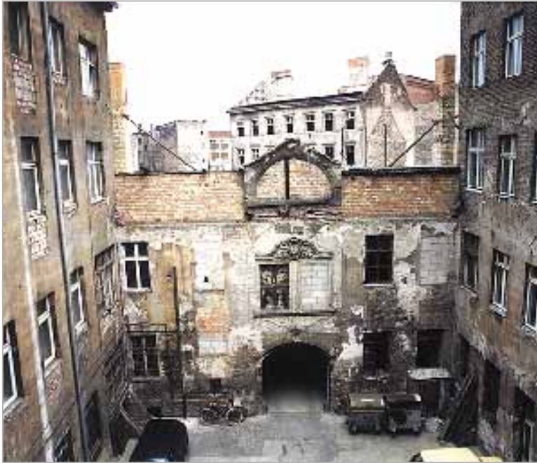
Gipsstraße 11, vor der Sanierung
