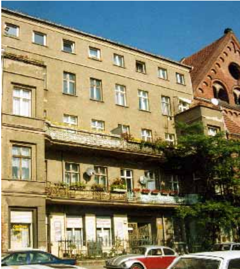
Auguststraße 91 mit ahistorischer Aufstockung, 1992
