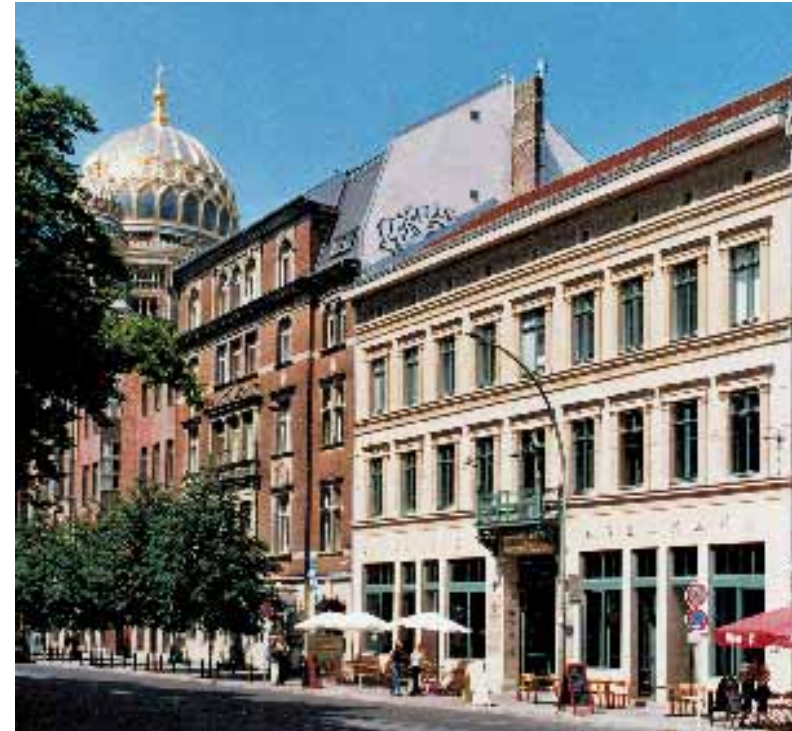
Oranienburger Straße 27, Straßenfassade nach der Sanierung
